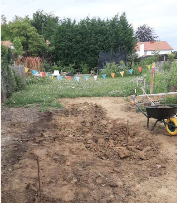
Uitgraven infiltratiekom: opvang water tuinberging en terrasoverkapping
