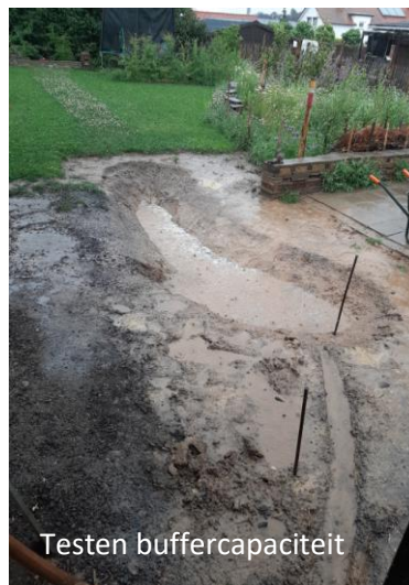
Aanleg infiltratiekom: deels opgevuld met zand afkomstig van onder de stoeptegels
