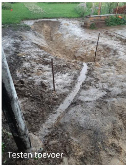
Aanleg infiltratiekom: deels opgevuld met zand afkomstig van onder de stoeptegels
