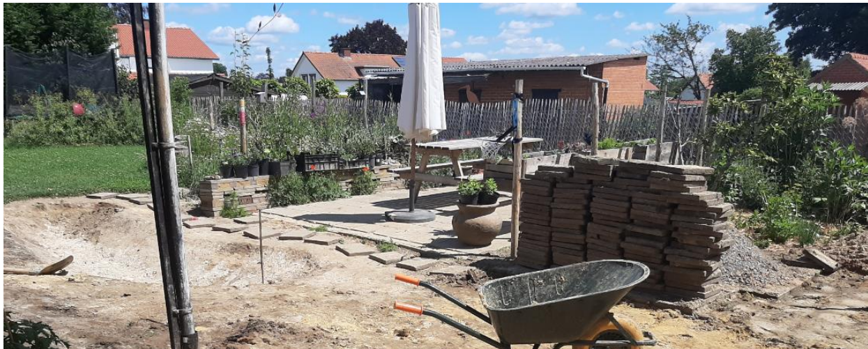
Aanleg infiltratiekom: deels opgevuld met zand afkomstig van onder de stoeptegels
